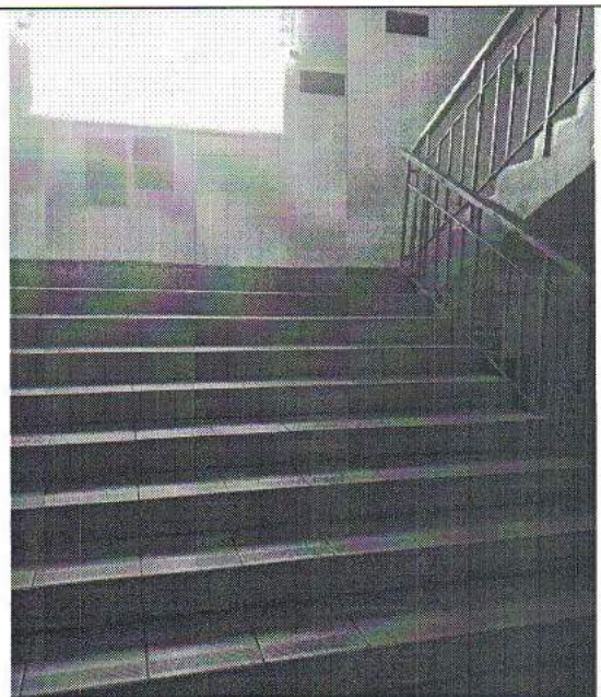
Фото №12 – Пути движения внутри здания
